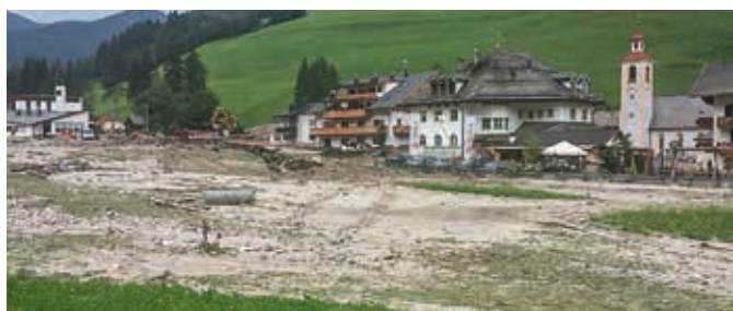
I danni alla frazione di Ferrara di Braies
