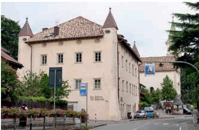
Im Lamplhaus, der Geburtsstätte der Raiffeisenkasse Bozen, befindet sich jetzt die Filiale Rentsch.
